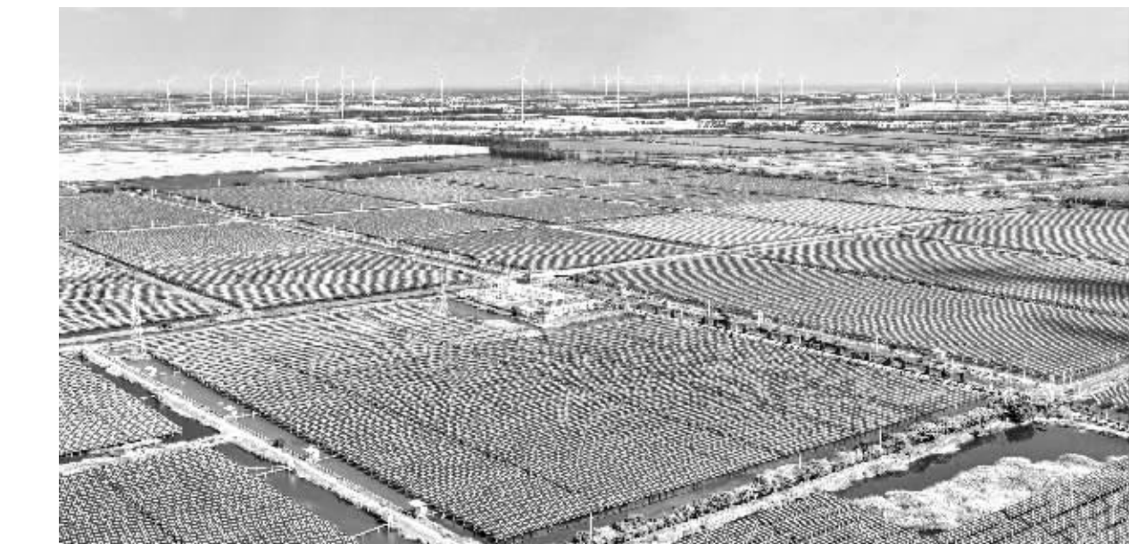
10月27日在江苏省宝应县柳堡镇拍摄的渔光互补发电项目和风电场项目（无人机照片）。
