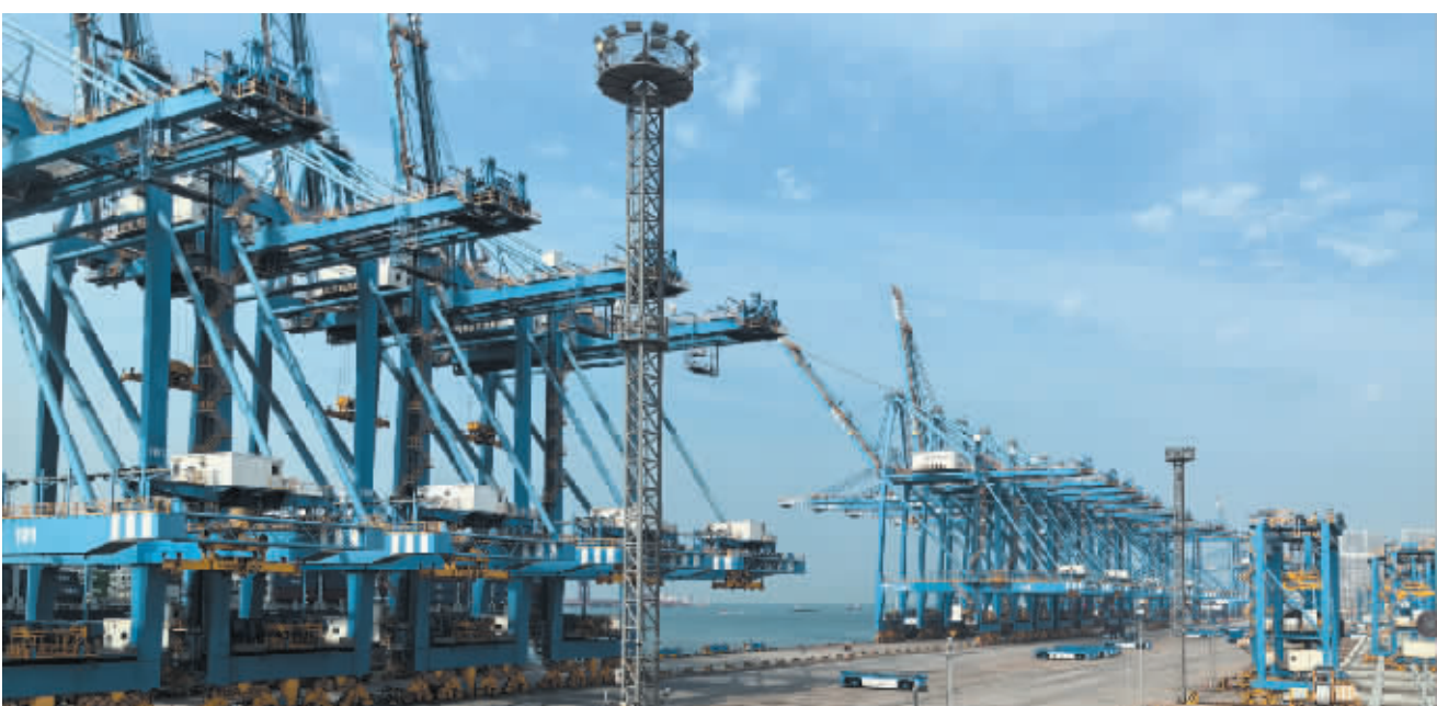
在青岛港全自动化集装箱码头,自动化桥吊正在作业。 本报记者 吴杨 摄
