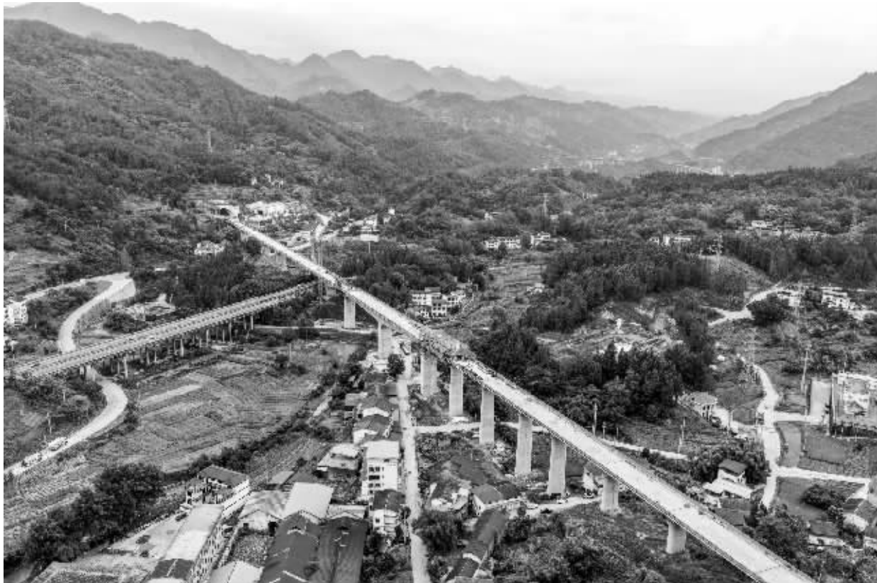
这是近日拍摄的西渝高铁庄子村跨沪蓉高速特大桥建设现场（无人机照片）。
