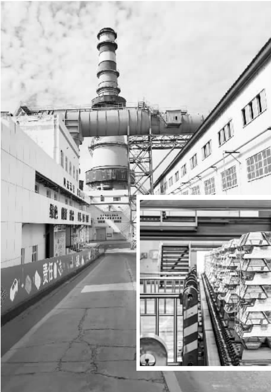
▲ 全国首个电解铝烟气污染物超低排放示范项目现场 ▼ 电投能源绿电铝产品正在霍煤鸿骏铝电公司下线
