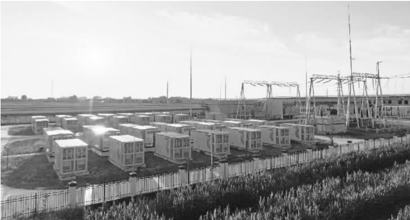
中核寒亭120MW/240MWH独立储能项目
