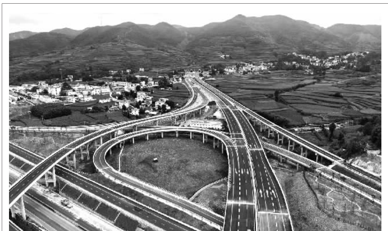
这是7月31日在云南省曲靖市会泽县拍摄的会泽北立交（无人机照片）。当日，云南宣威至会泽高速公路正式建成通车。作为滇东北路网重要组成部分，宣威至会泽高速公路全线总长96.74公里，采用双向四车道高速标准修建，设计时速80公里，为滇东北区域产业联动、乡村振兴注入强劲交通动能。 新华社图文
