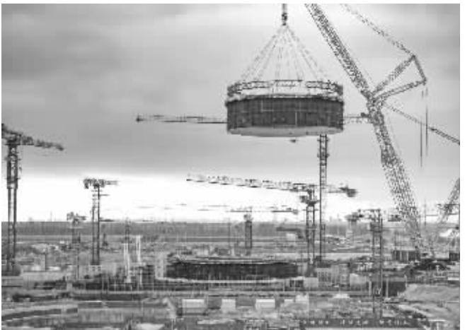
江苏徐圩核能供热发电厂1号机组核岛钢衬里模块吊装
