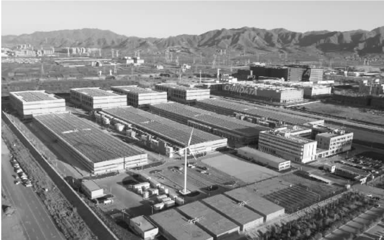
晶科科技助力腾讯落地风光储一体化数据中心项目
