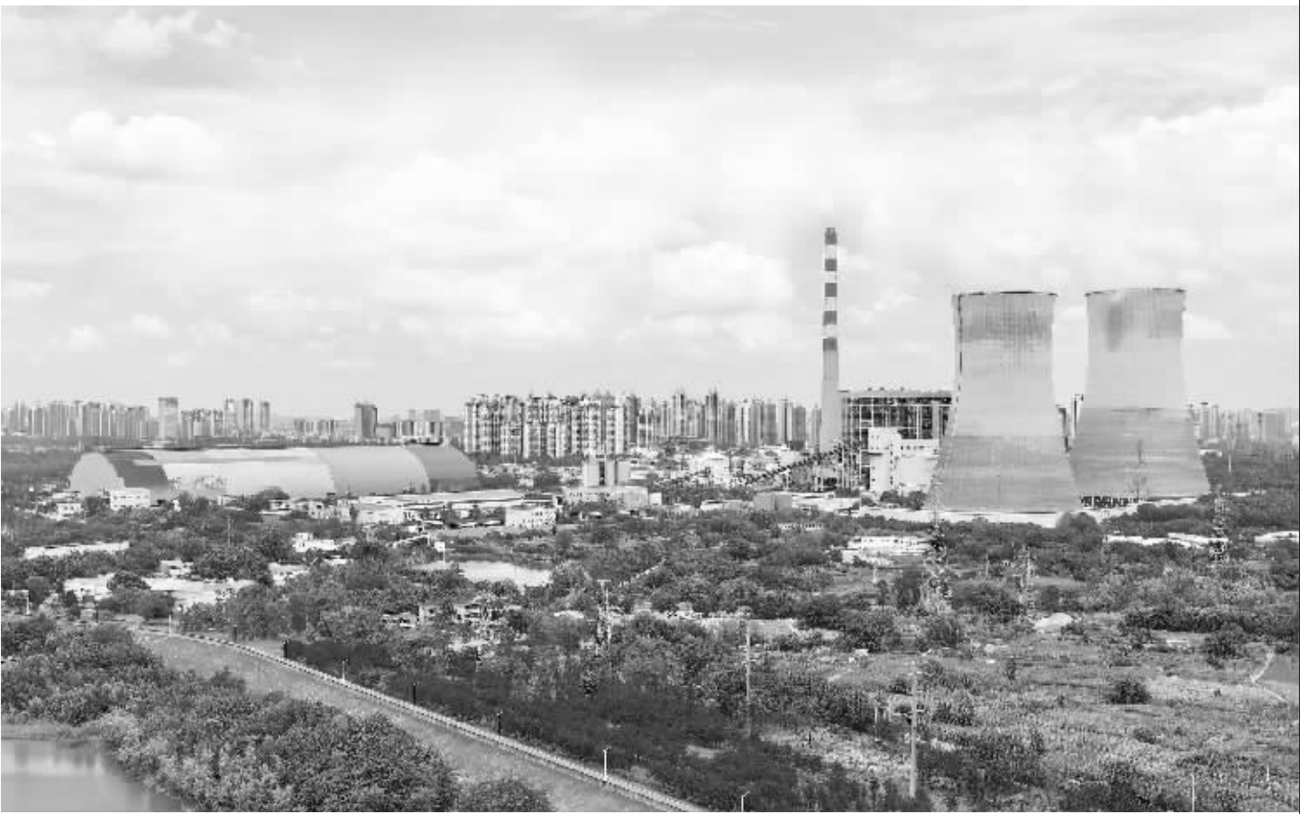
皖能电力所属皖能合肥发电公司
