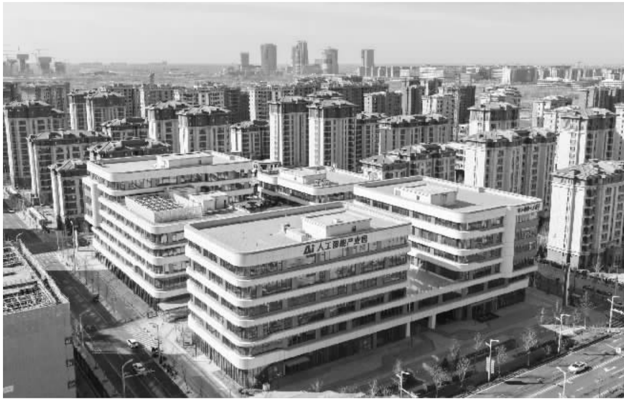
这是2026年3月18日拍摄的雄安新区人工智能产业园(无人机照片)。
