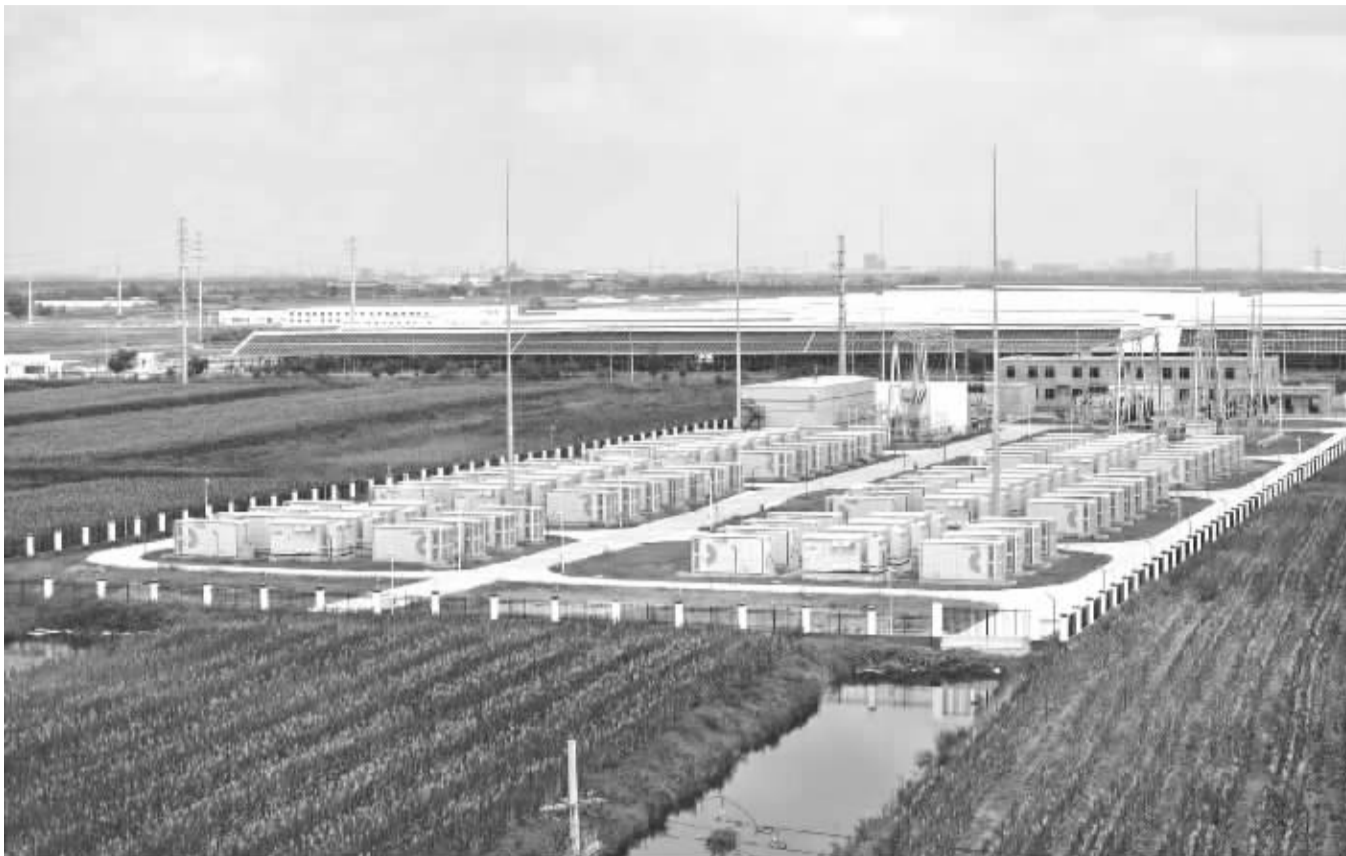
中核寒亭120MW/240MWh独立储能项目
