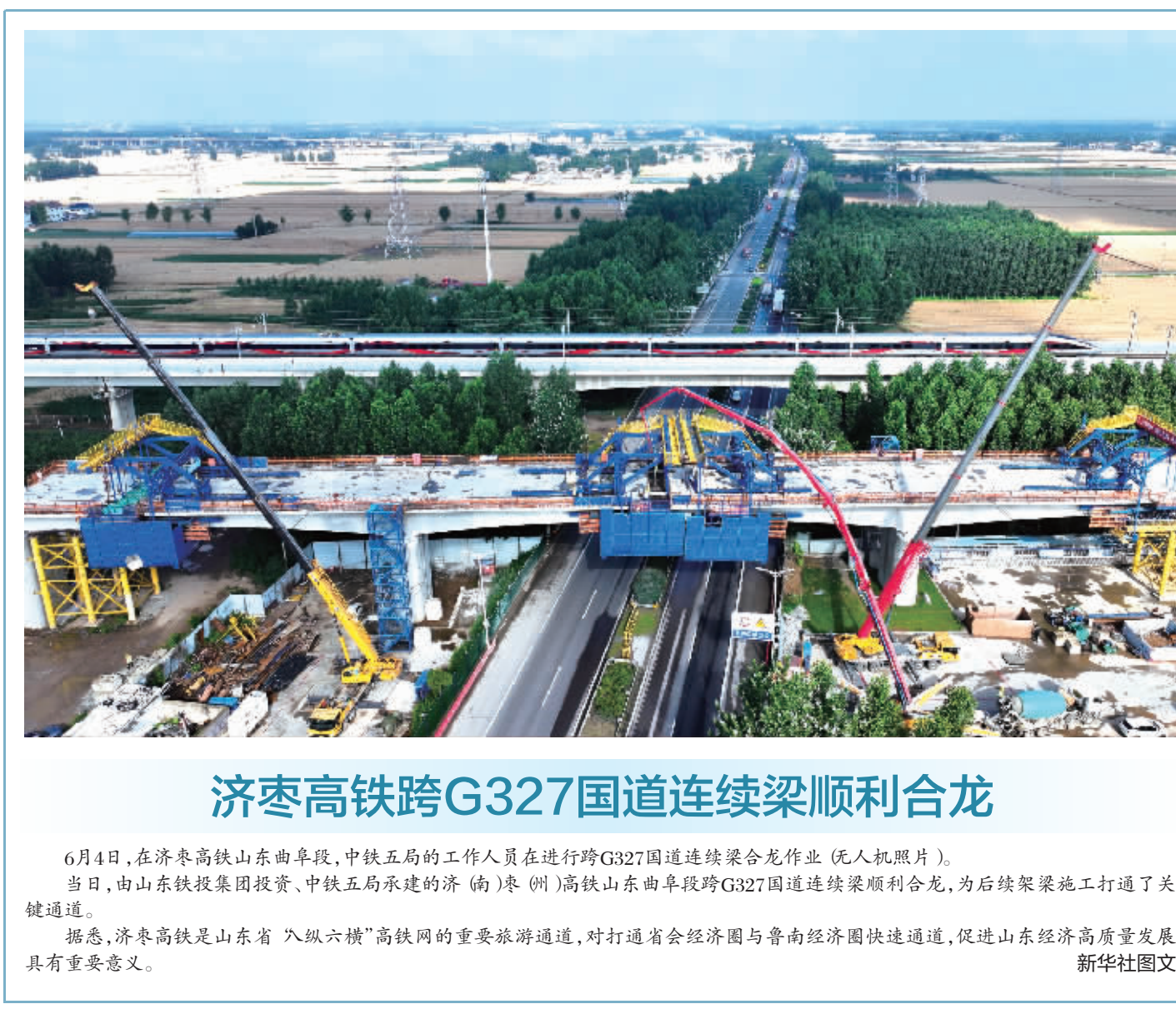
济枣高铁跨G327国道连续梁顺利合龙
