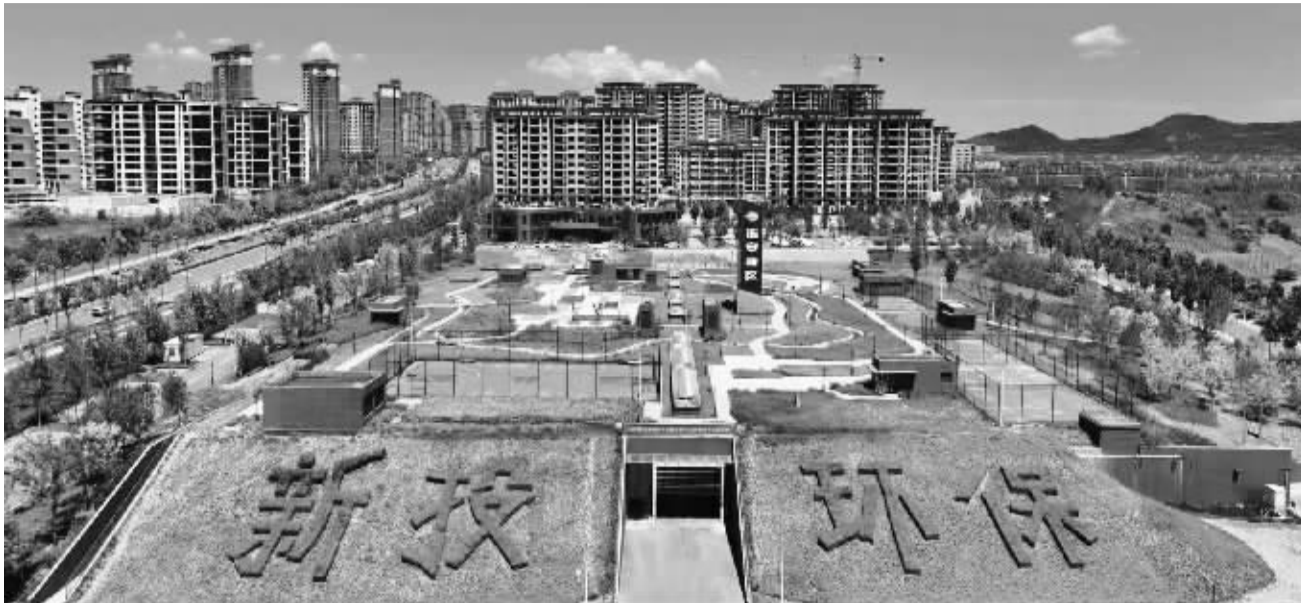
陕建股份投资运营的延安新区地下污水处理厂
