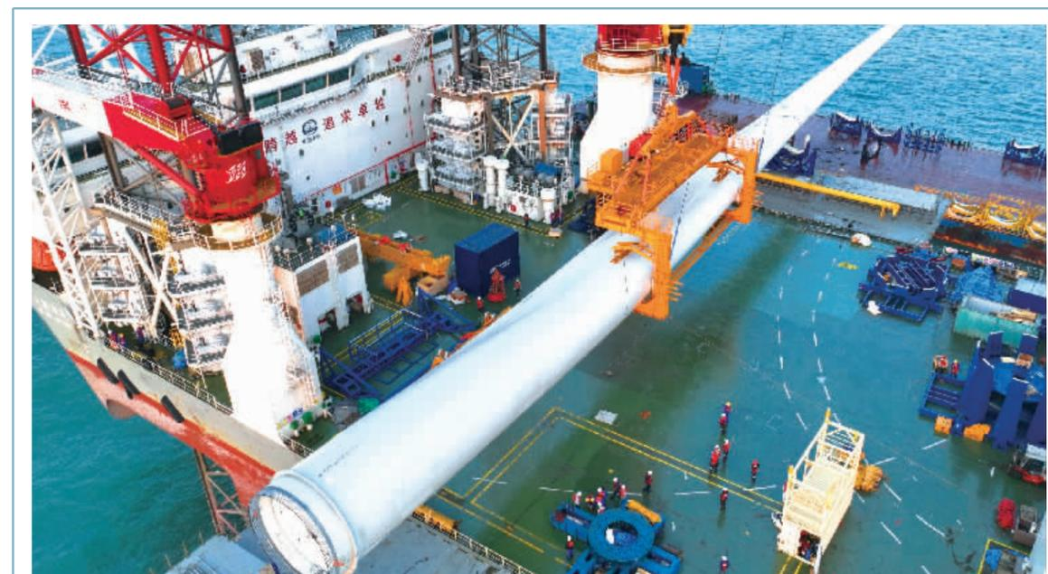
近日，在闽南海域吊装的20兆瓦海上风电机组第三片叶片在起吊中(无人机照片)。
