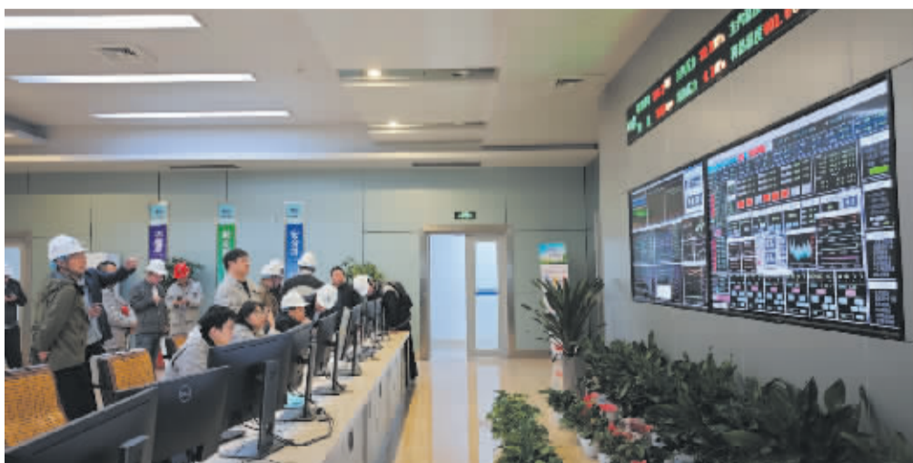
元琛科技沙洲电力百万机组现场
