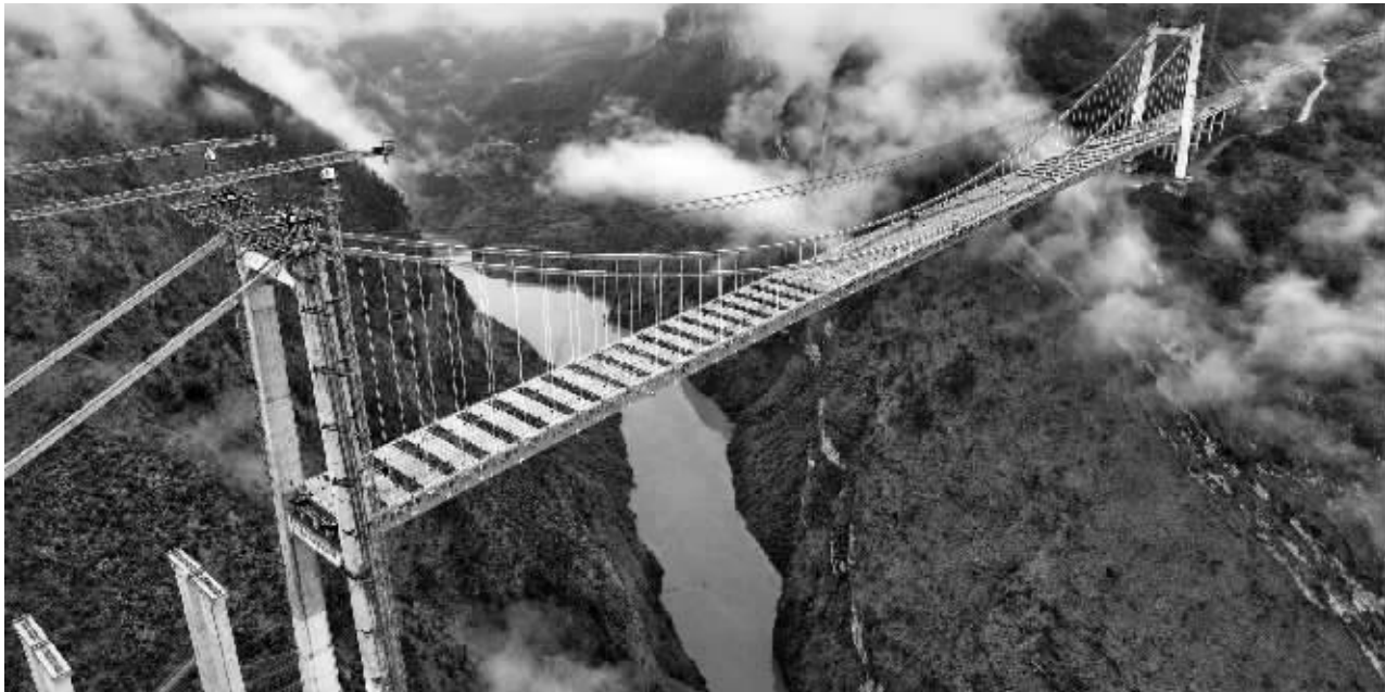
这是9月23日拍摄的天门特大桥(无人机照片)。9月23日,由中铁广州局等单位承建的贵州安(安顺)盘(盘州)高速天门特大桥成功合龙。天门特大桥是安顺至盘州高速公路的重要控制性工程,大桥全长1553米,桥面距离峡谷水面约560米。
