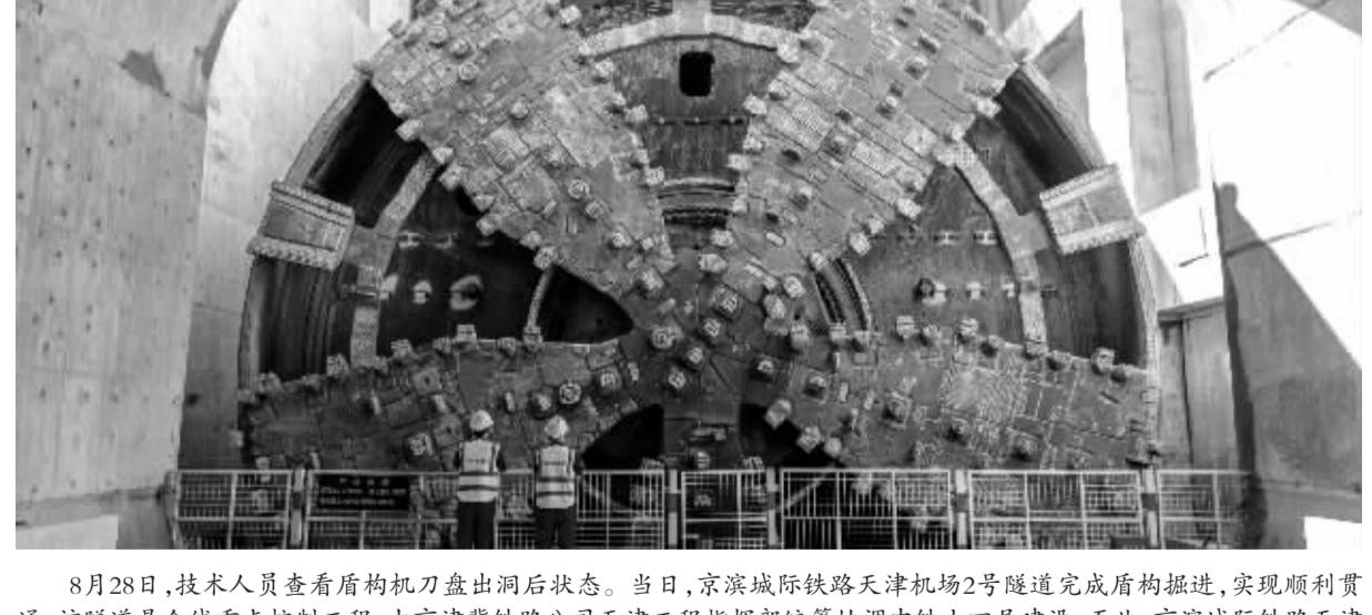
8月28日,技术人员查看盾构机刀盘出洞后状态。当日,京滨城际铁路天津机场2号隧道完成盾构掘进,实现顺利贯通。该隧道是全线重点控制工程,由京津冀铁路公司天津工程指挥部统筹协调中铁十四局建设。至此,京滨城际铁路天津机场盾构隧道全部安全贯通,为全线铺轨和后续通车奠定了基础。新华社发
