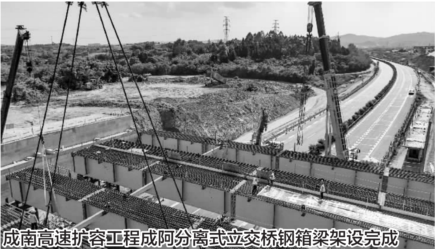
图为6月10日工人在成南高速扩容工程成阿分离式立交桥钢箱梁架设现场进行施工作业(无人机照片)。据了解,成南高速是国家“十纵十横”综合运输大通道横六线“沿江运输通道”的组成部分。成南高速的扩容将进一步保障国家公路主通道的畅通,改善沿线交通出行条件,促进成渝地区双城经济圈发展。
