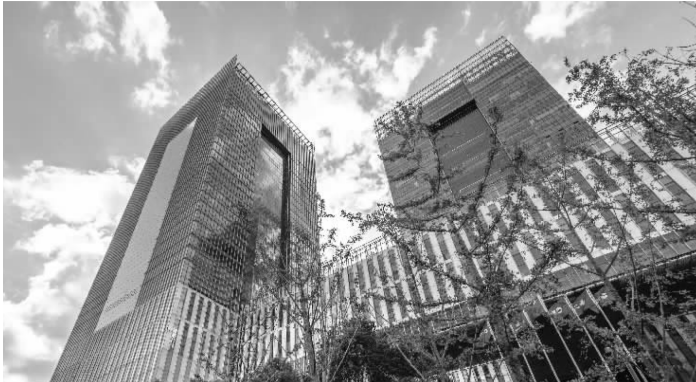
上海证券交易所新大楼
