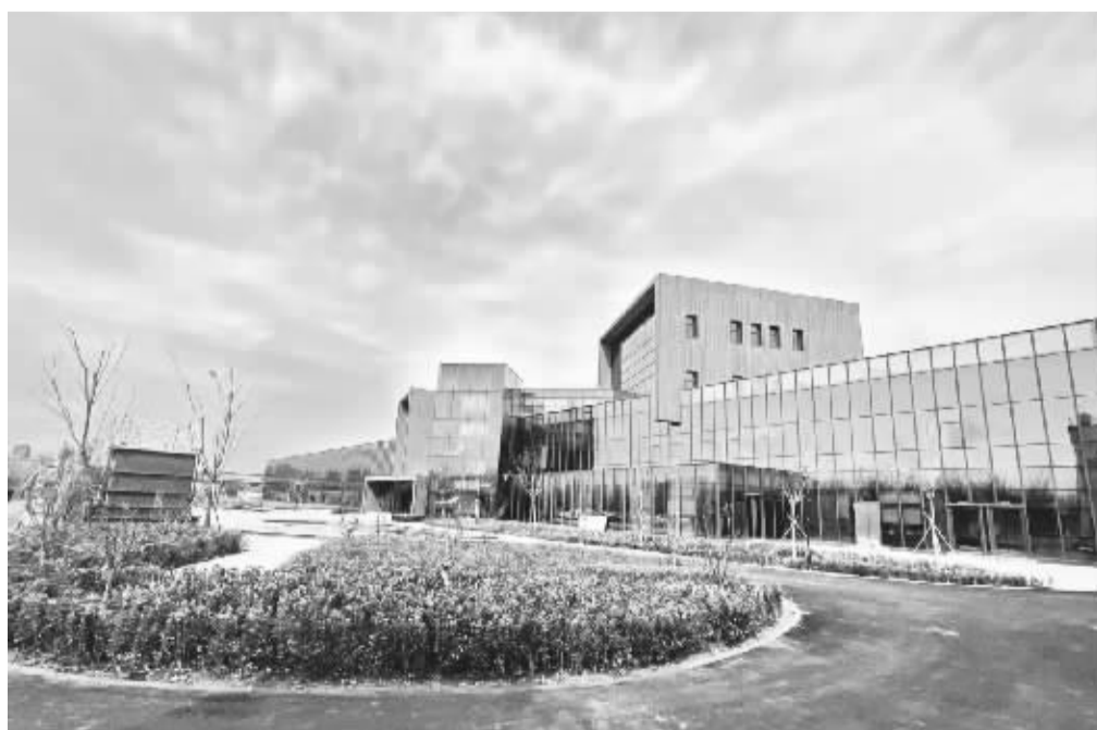
首创环保东坝再生水厂
