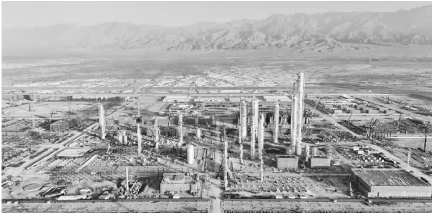
中油工程承建的塔里木120万吨/年二期乙烯项目
