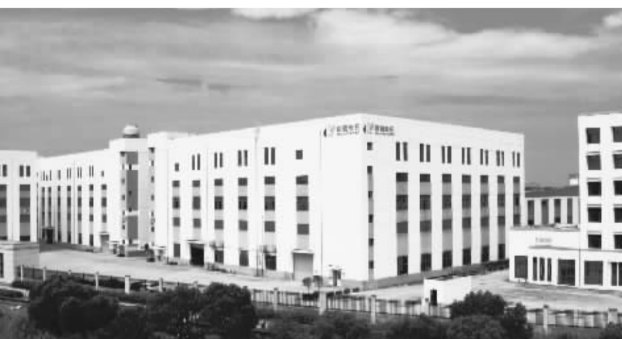
科强股份总部大楼
