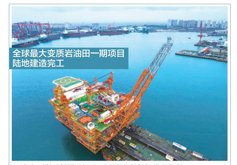
这是11月14日清晨在山东青岛拍摄的渤中26-6油田一期开发项目中心平台装船作业现场 (无人机照片)。 当日,全球最大变质岩油田渤中26-6油田一期开发项目中心平台在山东青岛完成装船作业,后续将赴渤海南部海域,进入海上安装 和联调阶段,这标志着该项目陆地建造完工。
