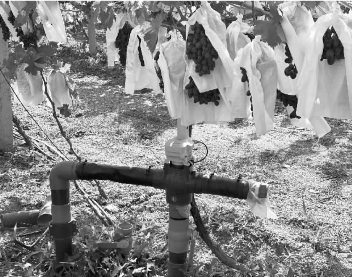
新疆和硕县葡萄园里安装的极飞智能灌溉阀
