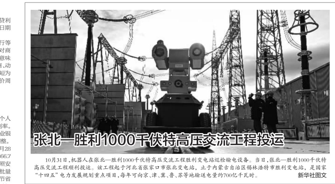
10月31日,机器人在张北—胜利1000千伏特高压交流工程胜利变电站巡检输电设备。当日,张北—胜利1000千伏特高压交流工程顺利投运。该工程起于河北省张家口市张北变电站,止于内蒙古自治区锡林浩特市胜利变电站,是国家“十四五”电力发展规划重点项目,每年可向京、津、冀、鲁、苏等地输送电量约700亿千瓦时。
