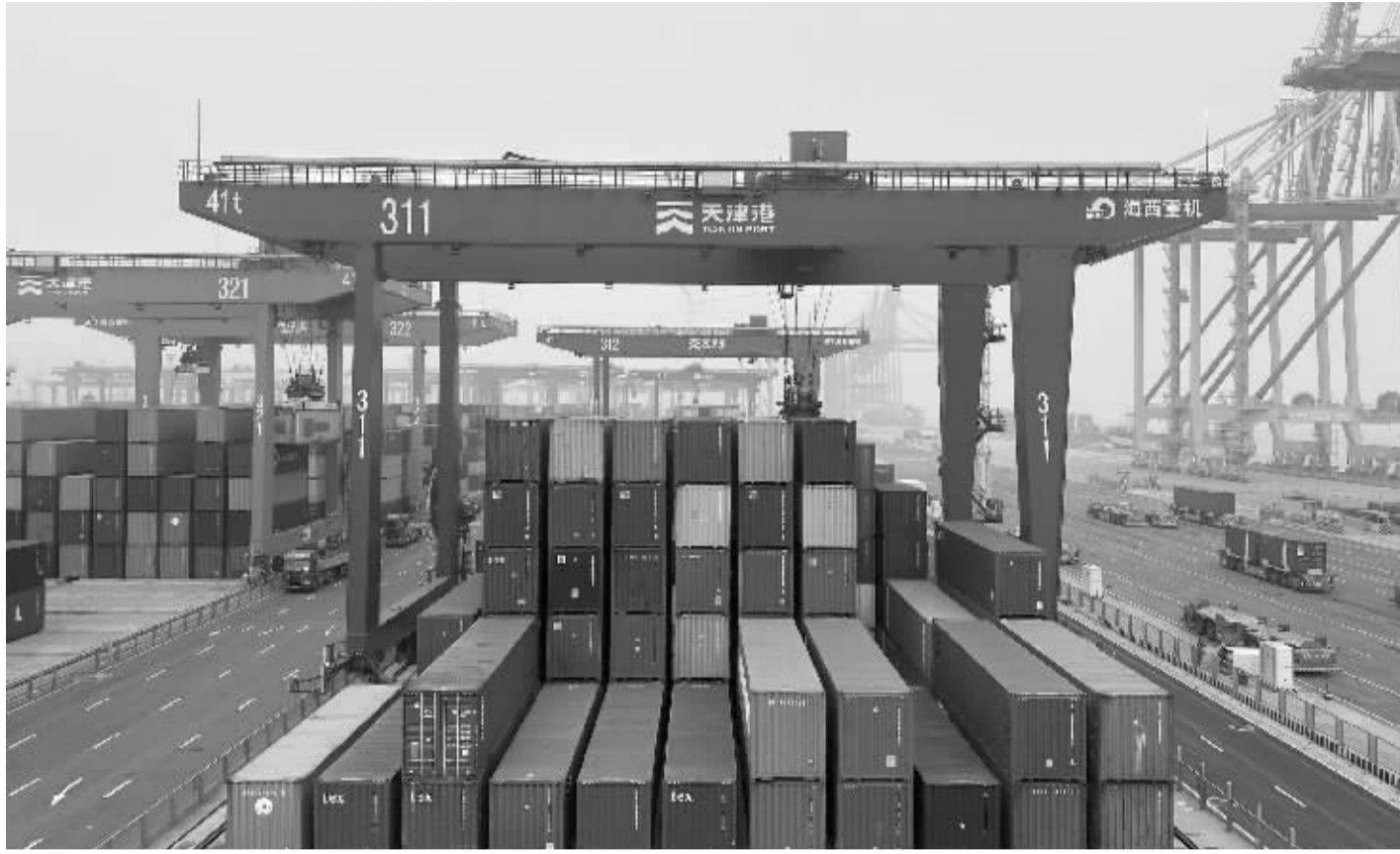
天津港第二集装箱码头有限公司智能化码头
