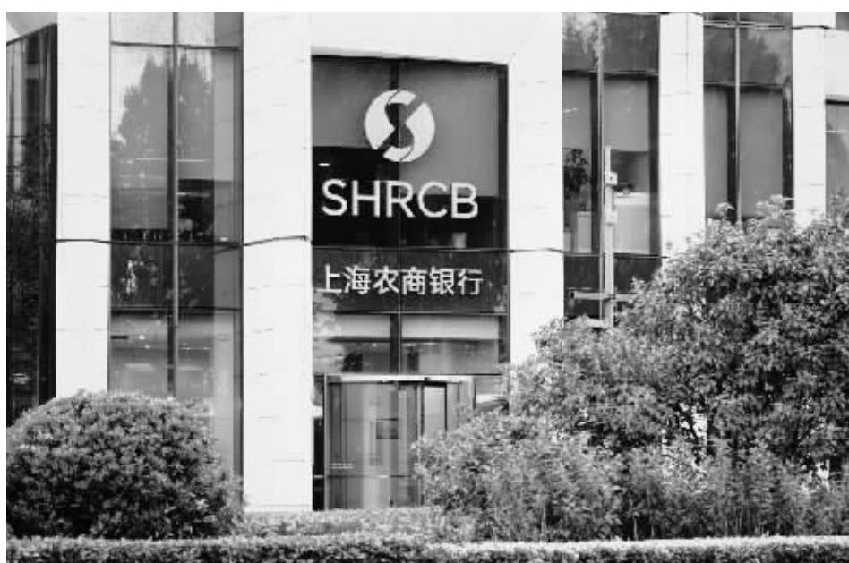
上海农商银行（沪农商行）总部大楼
