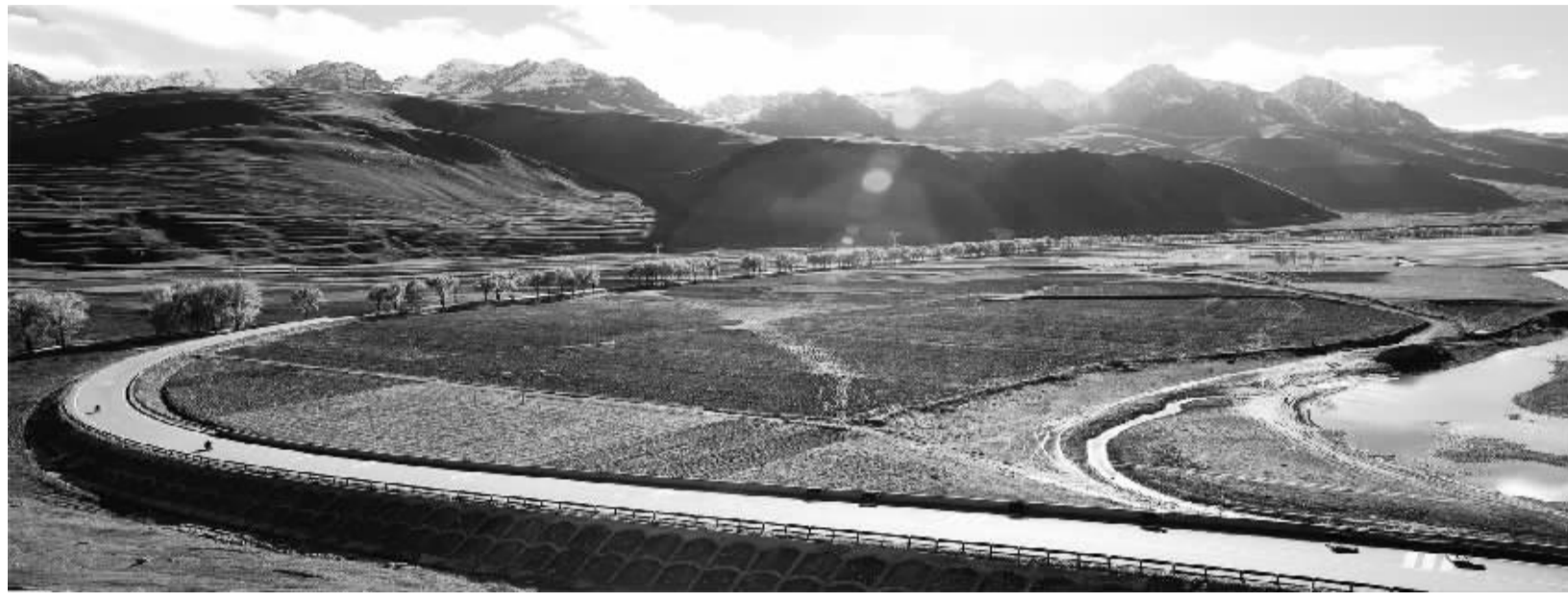
成都路桥参与修建的映秀至汶川高速公路
