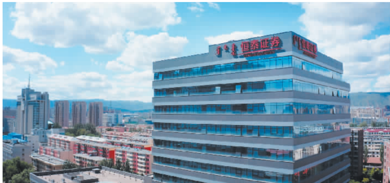
恒泰证券办公大楼
