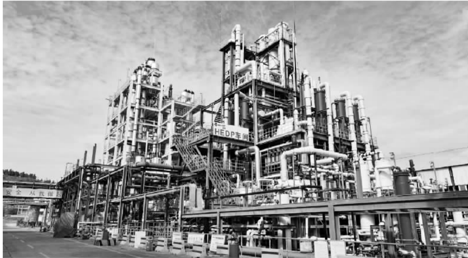
泰和科技的HEDP生产线
