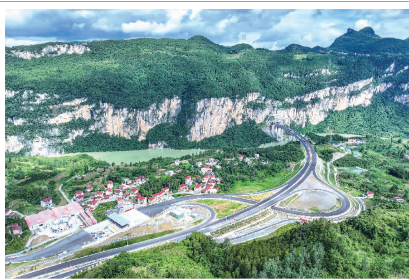
渝湘复线高速 彭西路标段进入收尾阶段 这是8月2日拍摄的渝湘复线高速彭西路标段龚滩互通建设现场（无人机照片）。目前，由中铁二十局承建的渝湘复线高速彭西路标段进入收尾施工阶段，施工人员进行全域检查、路面清洁以及附属设施安装等工作。渝湘复线高速公路总里程280公里，由巴南至彭水、彭水至酉阳、武陵至道真3条路组成，平均桥隧比80%。 新华社图文
