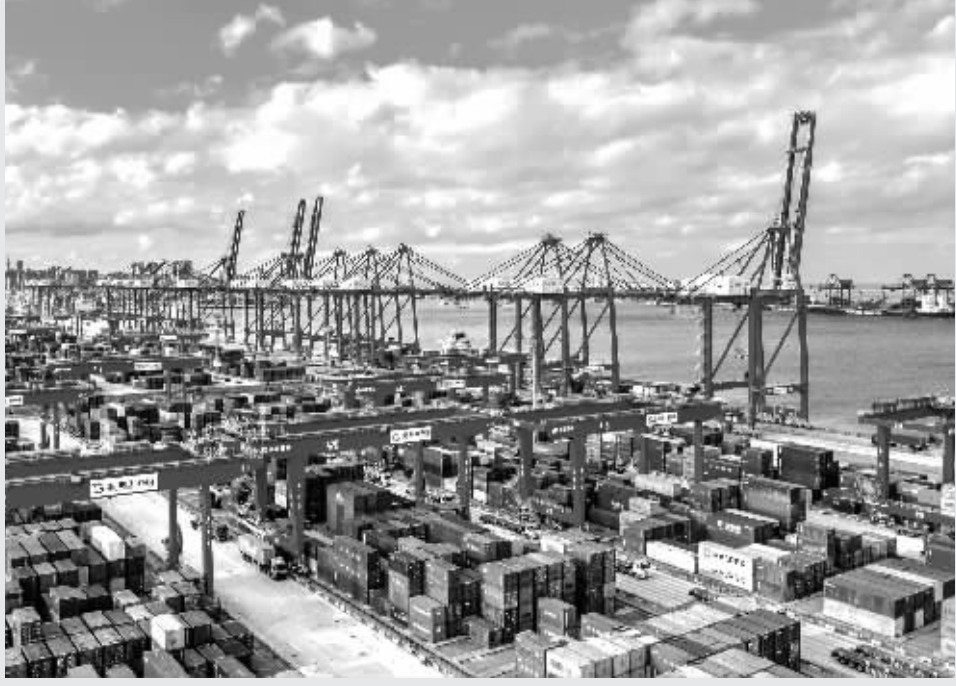
2024年7月2日拍摄的山东港口日照港集装箱码头(无人机照片)。
