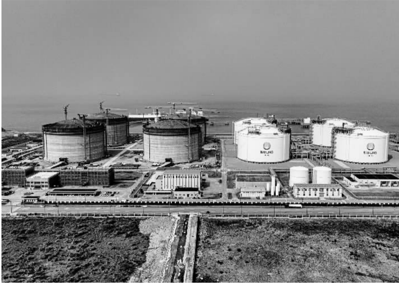
新奥舟山LNG接收站一、二、三期储罐
