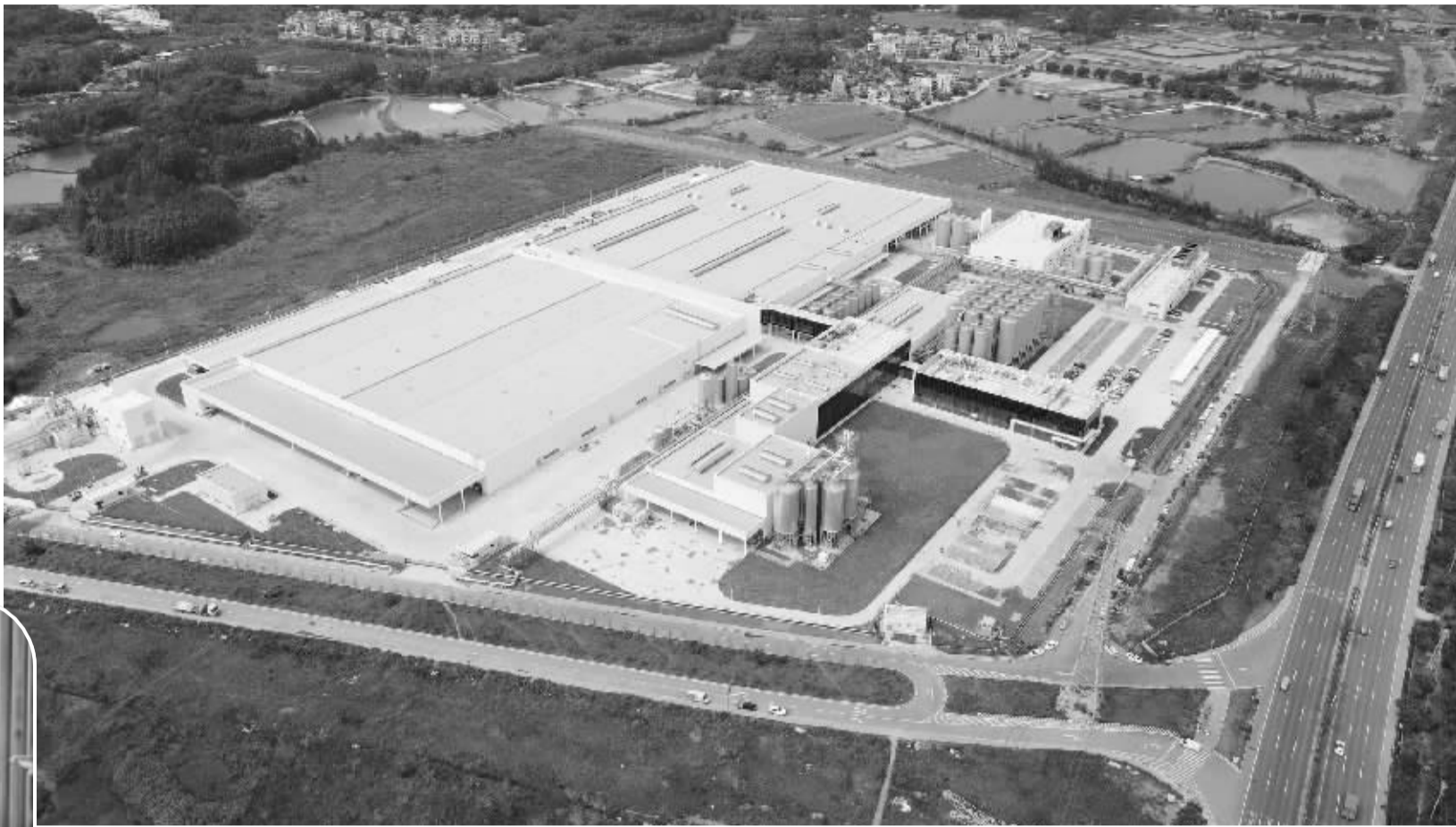
▲重庆啤酒即将于佛山投产的“海绵酒厂”。该酒厂地下设置容积3000立方米的雨水收集处理系统，雨水经过处理后作为清洁绿化和非工艺接触生产用水，进一步节约淡水资源。
