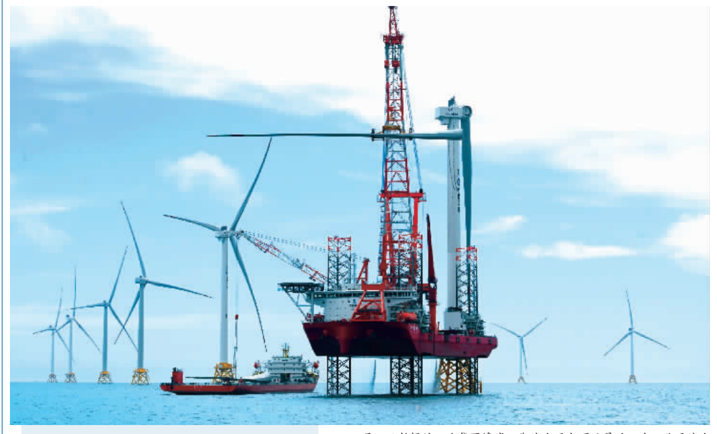
全國首個批量化應用單機容量16兆瓦海上風電機組項目并网發電
