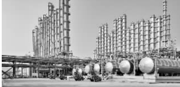
通威股份旗下永祥股份硅料厂的蒸馏塔
