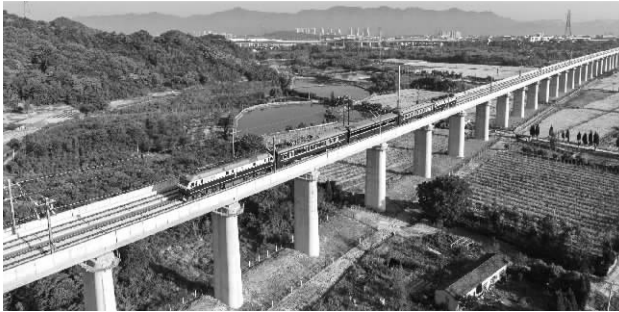
5月18日,杭温高铁检测列车驶过浦江特大桥(无人机照片)。当日,杭州至温州高速铁路启动联调联试,进入工程验收关键阶段。杭温高铁线路全长260公里,设计时速350公里。
