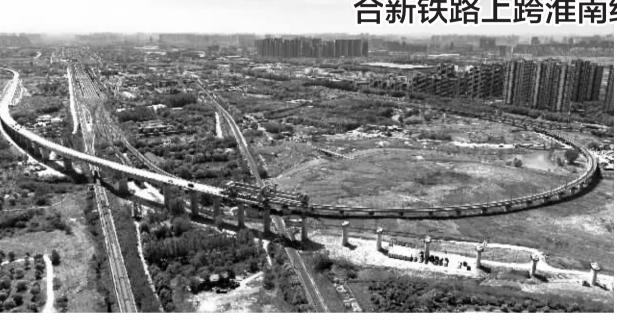
这是4月24日拍摄的 合新铁路上跨既有铁路淮 南上行线架梁施工现场 (无人机照片)。
