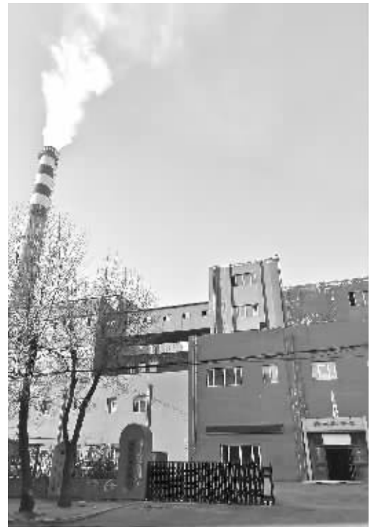
位于飞翔路1号的滑翔二号热源厂
