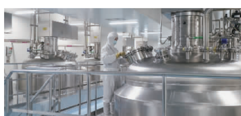
东北制药维生素C原料药生产线
