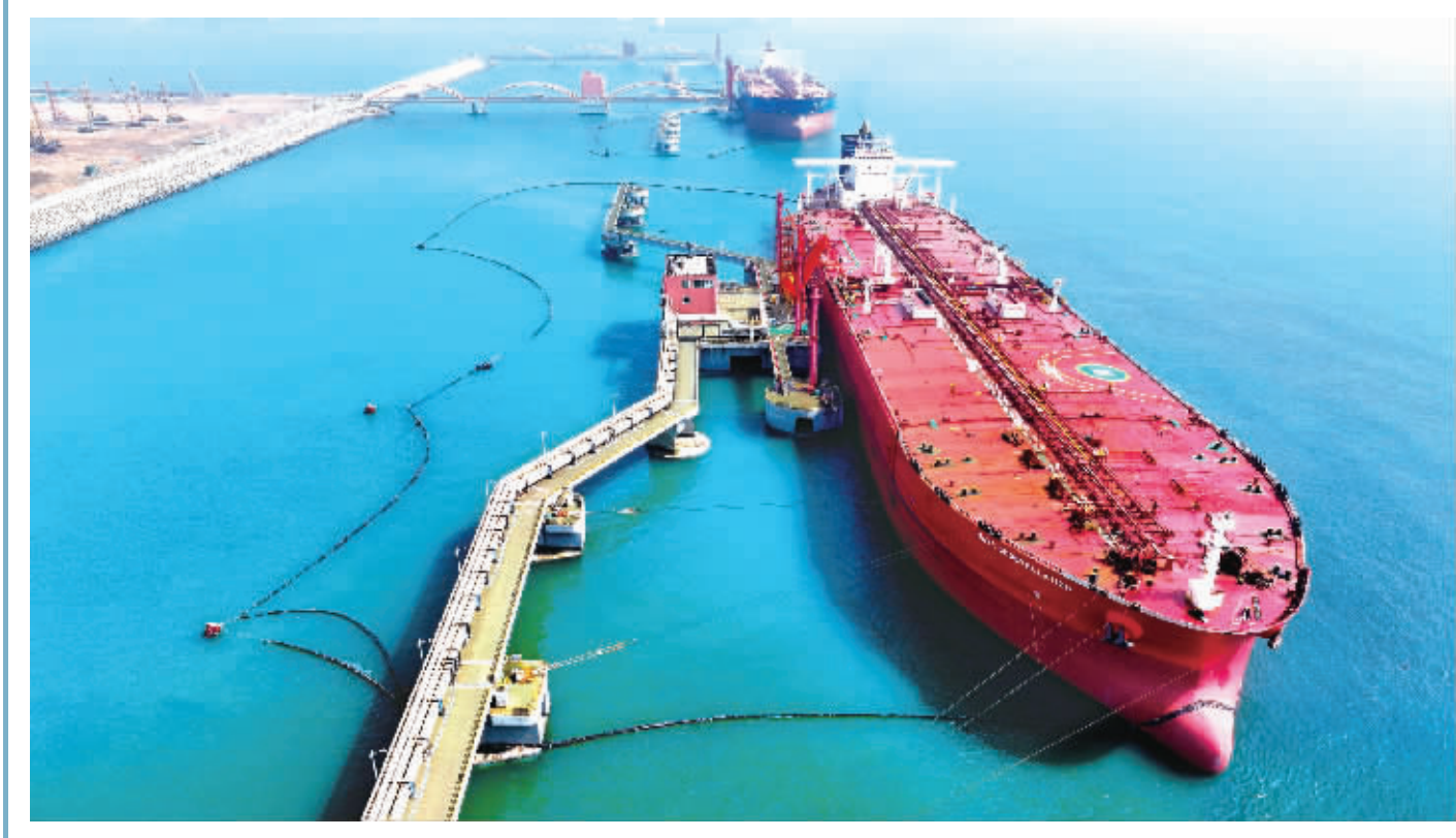
前两月日照港油品业务完成吞吐量同比增长7.5% 3月29日,在山东港口日照港岚山区30万吨级油品码头,船舶停靠进行卸油作业(无人机照片)。近年来,山东港口日照港充分发挥联动陆海、东西互助、衔接南北的区位优势,着力打造北方能源枢纽港,目前已建成4座30万吨级原油码头。2024年1月至2月,日照港油品业务完成吞吐量1403万吨,同比增长7.5%。 新华社图文
