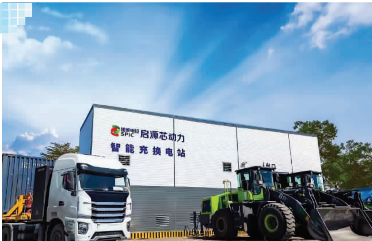
中国电力绿电交通板块启源芯动力智能换电站项目 公司供图
