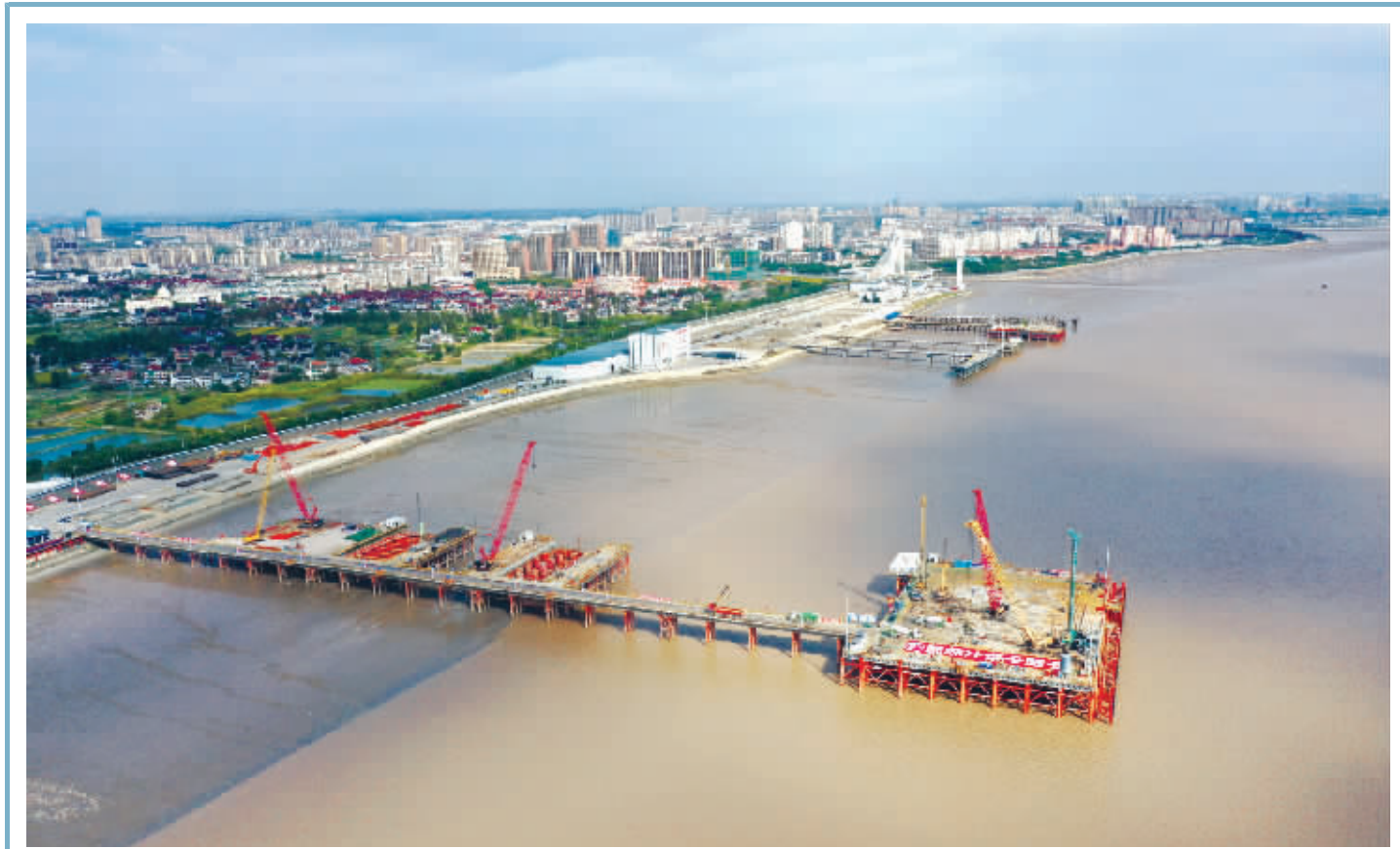
10月22日拍摄的杭州湾跨海铁路桥北航道桥主塔墩桩基施工平台（无人机照片）。当日，杭州湾跨海铁路桥首个主塔墩桩基施工完成，大桥建设取得阶段性进展。杭州湾跨海铁路桥全长29.2公里，包括北、中、南3座航跨桥和跨大堤、海中、浅滩区引桥，属超长高速铁路桥梁集群工程。 新华社图文
