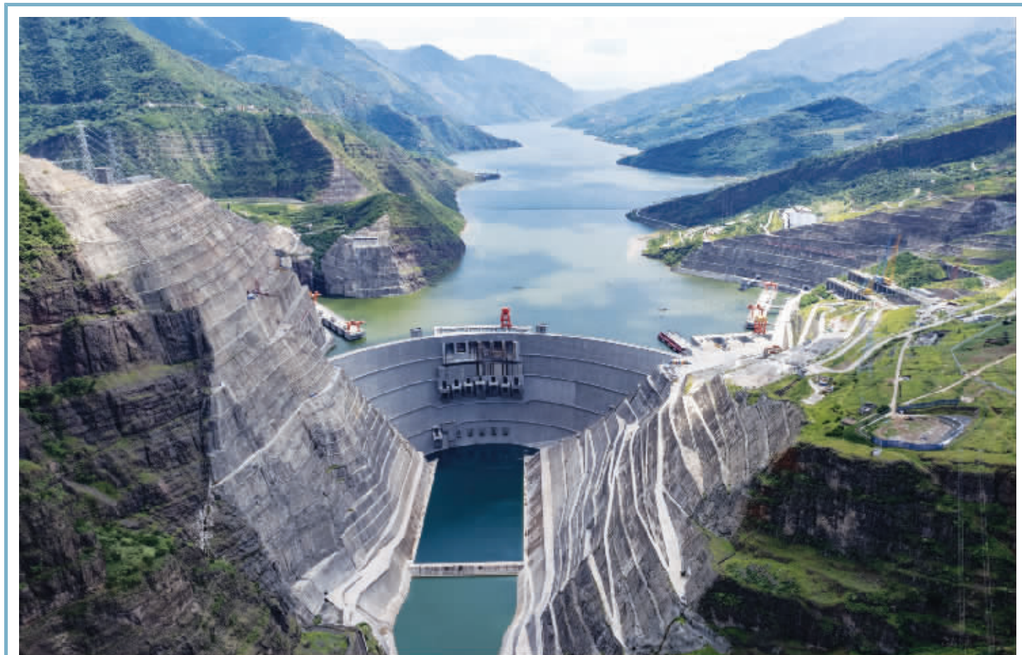
白鹤滩水电站累计发电量超946亿千瓦时 这是9月18日拍摄的白鹤滩水电站一景(无人机照片)。白鹤滩水电站位于云南省巧家县和四川省宁南县交界处金沙江干流河段,是仅次于三峡电站的世界第二大水电站,总装机容量1600万千瓦。截至2023年9月17日,白鹤滩水电站累计发电量超946亿千瓦时,有效带动周边地区发展的同时为我国经济社会发展注入强劲动力。新华社图文
