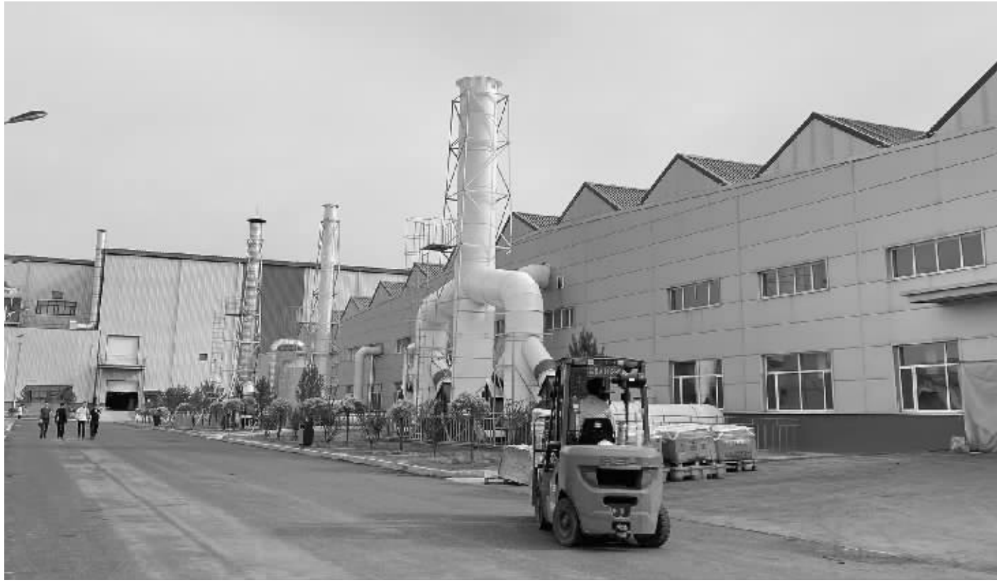
华耀光电厂区拉晶切片车间外景
