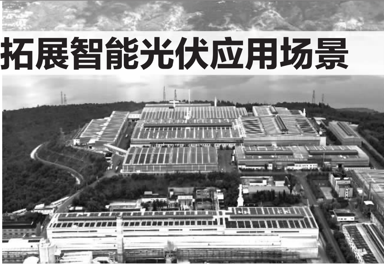
图为昆明阳宗海绿色铝产业园绿色智慧能源示范项目
