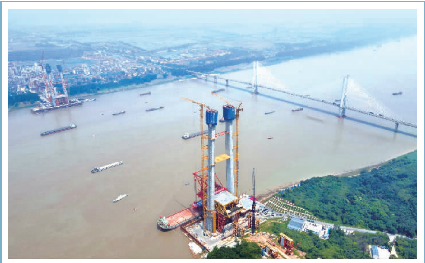
京台高速铜陵长江公铁大桥4号主塔封顶 6月2日拍摄的封顶后的京台高速铜陵长江公铁大桥4号主塔(画面正中)(无人机照片)。当日，由中铁大桥局承建的京台高速铜陵长江公铁大桥4号主塔顺利封顶，跨江主桥首节段钢梁开始架设。该桥是一座双层斜拉—悬索协作体系大桥，主跨988米，具有高速公路、城际铁路、货运铁路三种过江功能。
