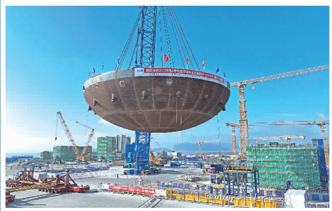
浙江三门核电二期工程4号机组核岛钢制安全壳底封头吊装就位 这是5月29日拍摄的三门核电二期工程4号机组核岛钢制安全壳底封头吊装现场（无人机照片）。5月29日，在浙江省台州市三门县，三门核电二期工程4号机组核岛钢制安全壳底封头顺利吊装就位。这是4号机组核岛反应堆厂房吊装的首个大型模块，标志着该厂房主体结构施工开始。三门核电二期工程4号机组于3月22日开工，整个二期工程建成投产后，一、二、三期总装机容量将达到500万千瓦，年发电量预计可达到400亿千瓦时。 新华社图文
