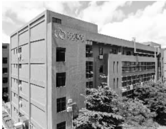
云里物里办公大楼
