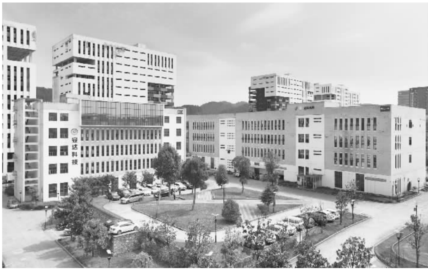
安达科技办公楼
